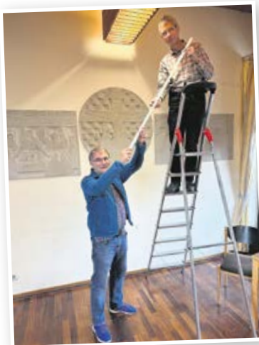
„Es werde Licht“ – Rüdiger Schaarschmidt und Rainer Klosse aus dem GKR haben im Gemeindehaus das Lichtkonzept überarbeitet und Energiesparlampen der neuesten Generation eingebaut
